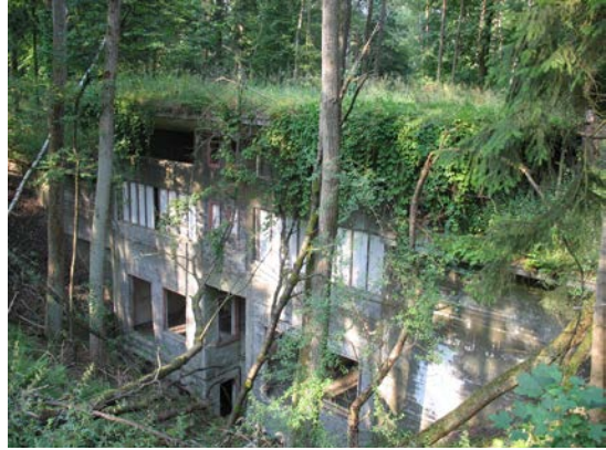
Produktionsgebäude 9368 – eines von 400 baulichen Relikten der ehemaligen Pulverfabrik Liebenau. © Martin Guse. Dokumentationsstelle Pulverfabrik Liebenau
