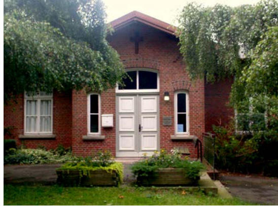
Sitz der Gedenkstätte Wehnen auf dem Gelände der Karl-Jaspers-Klinik: Das Gebäude der Alten Pathologie – ein Backsteinbau aus dem Jahr 1890. © Gedenkkreis Wehnen e. V.
