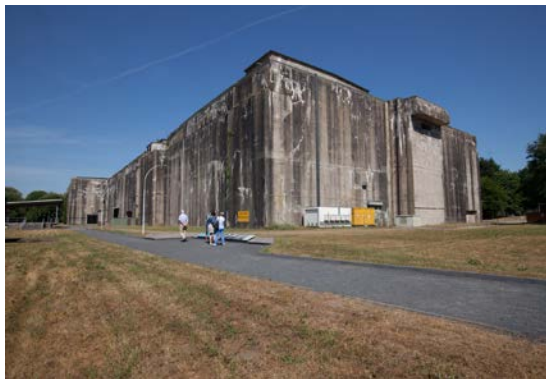
Der Denkort Bunker Valentin. © Henry Fried, 2018. Denkort Bunker Valentin / LzpB Bremen
